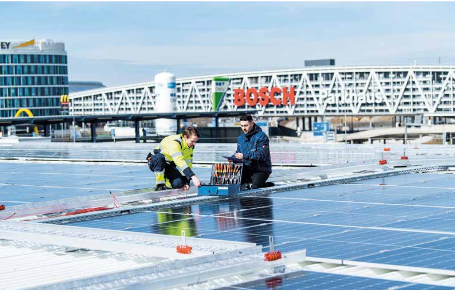
Panel für Panel zum Solarflughafen: Zuletzt bereitete der Landesairport die Dachfläche eines weiteren Parkhauses für den Ausbau seiner Fotovoltaikanlagen vor. Die Klimastrategie STRzero sieht viele solcher Projekte vor.
